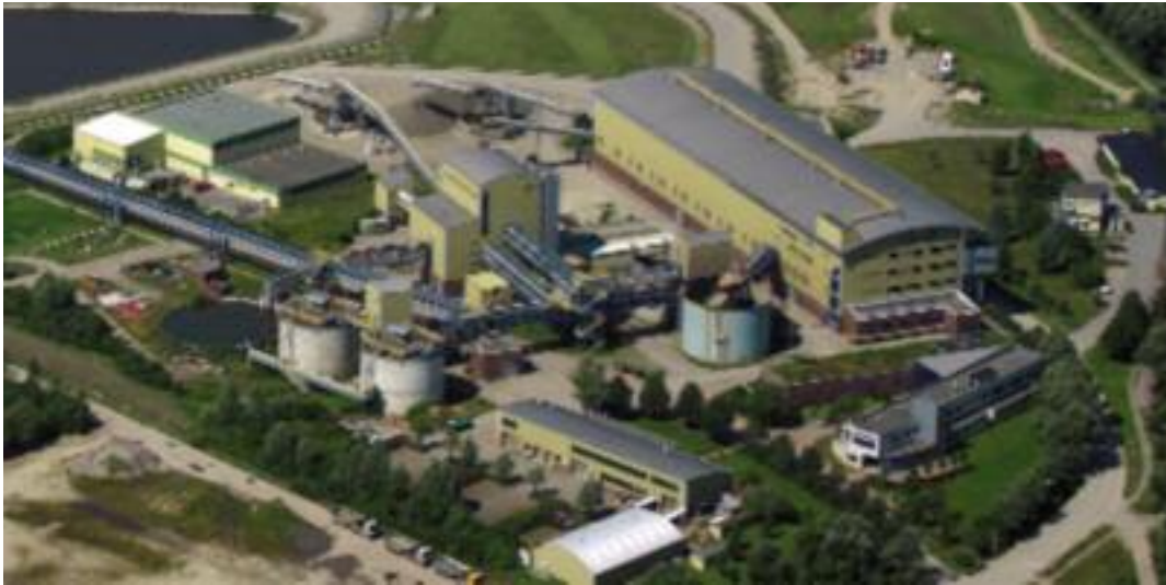
Die Metha, gelegen kurz vor Finkenwerder, ist Europas modernste Hafensediment-Aufbereitungsanlage
