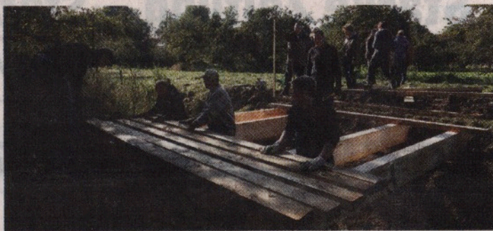
Eine Brücke wird gebaut damit das Grundstück auch mit dem Trecker zu bewirtschaften ist
